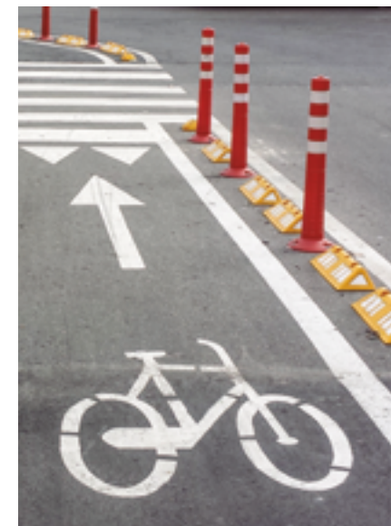
Ejemplo de hitos verticales de poliuretano, Bogotá
